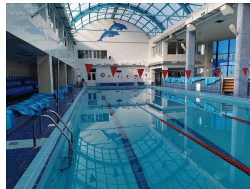
ДЮСШ, кап.ремонт чаши (2020 г., 27.08.21)
