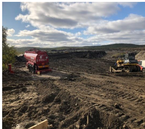
Сооружение №1 (Дровяное) (2021 г., 09.09.21)
